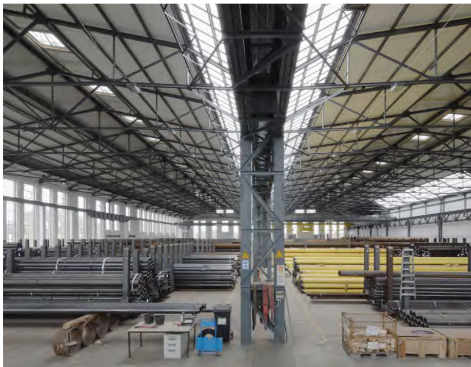
Willich, Halle 4 Pro Pipe, Stahlwerke Becker, HJPplaner
