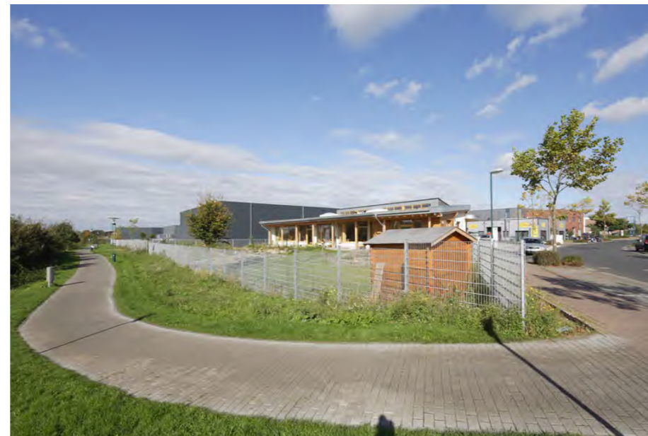
Willich, Stahwerke Becker, HJPplaner
